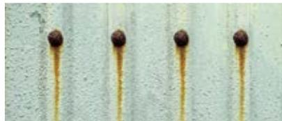
Cuando se juntan ciertos metales, puede haber una interacción negativa que provoque una corrosión temprana que no se produciría de otro modo. Lo más habitual es que se produzca entre los propios componentes metálicos y los accesorios utilizados para fijarlos al edificio (como clavos, tornillos y fijaciones).
